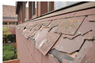
Asbesthaltige Schindeln
