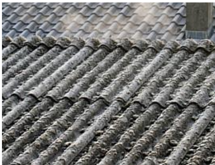
Typisches Dach mit Eternitplatten
